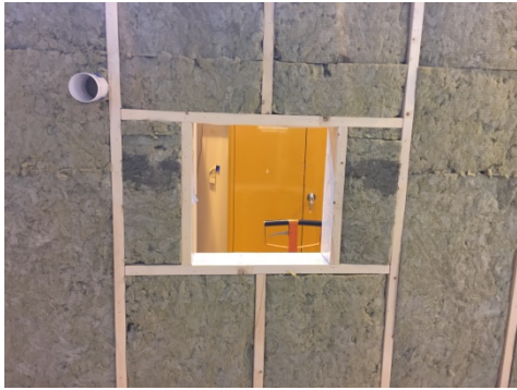
Montering av fönster och rör för ventilation
