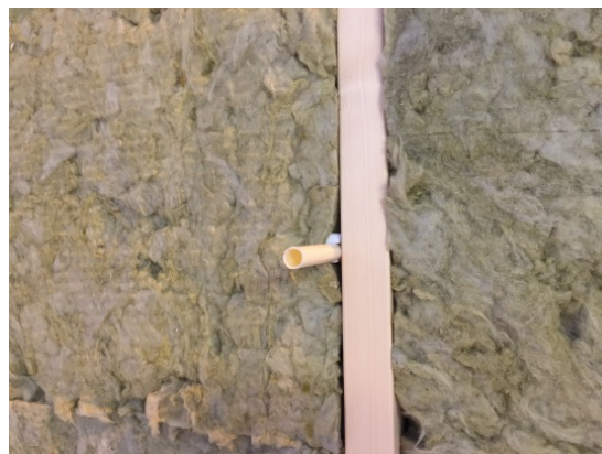
Bild 4. Montering av fönster och rör för ventilation Bild 5. Montering av rör för el
