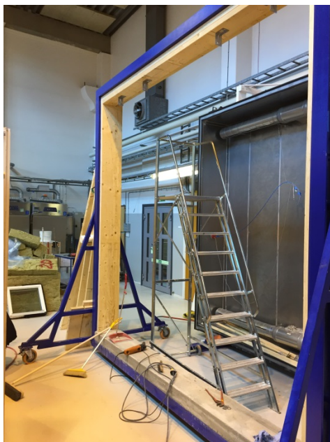
Bild 1. Provvägg under uppbyggnad
