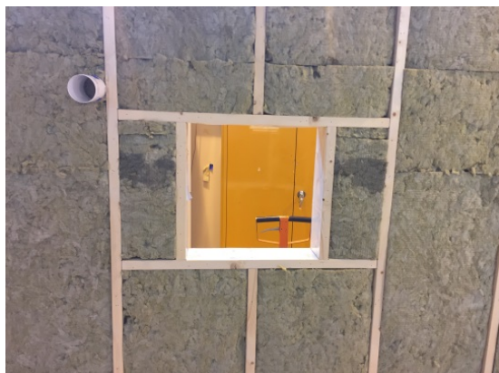
Bild 4. Montering av fönster och rör för ventilation Bild 5. Montering av rör för el
