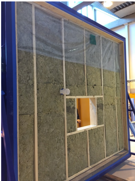
Provvuppställningen sedd från insidan före montage av läkt som ersätter regler för ett installationsskikt, endast en del av lufttätthetssystemet är monterat.
